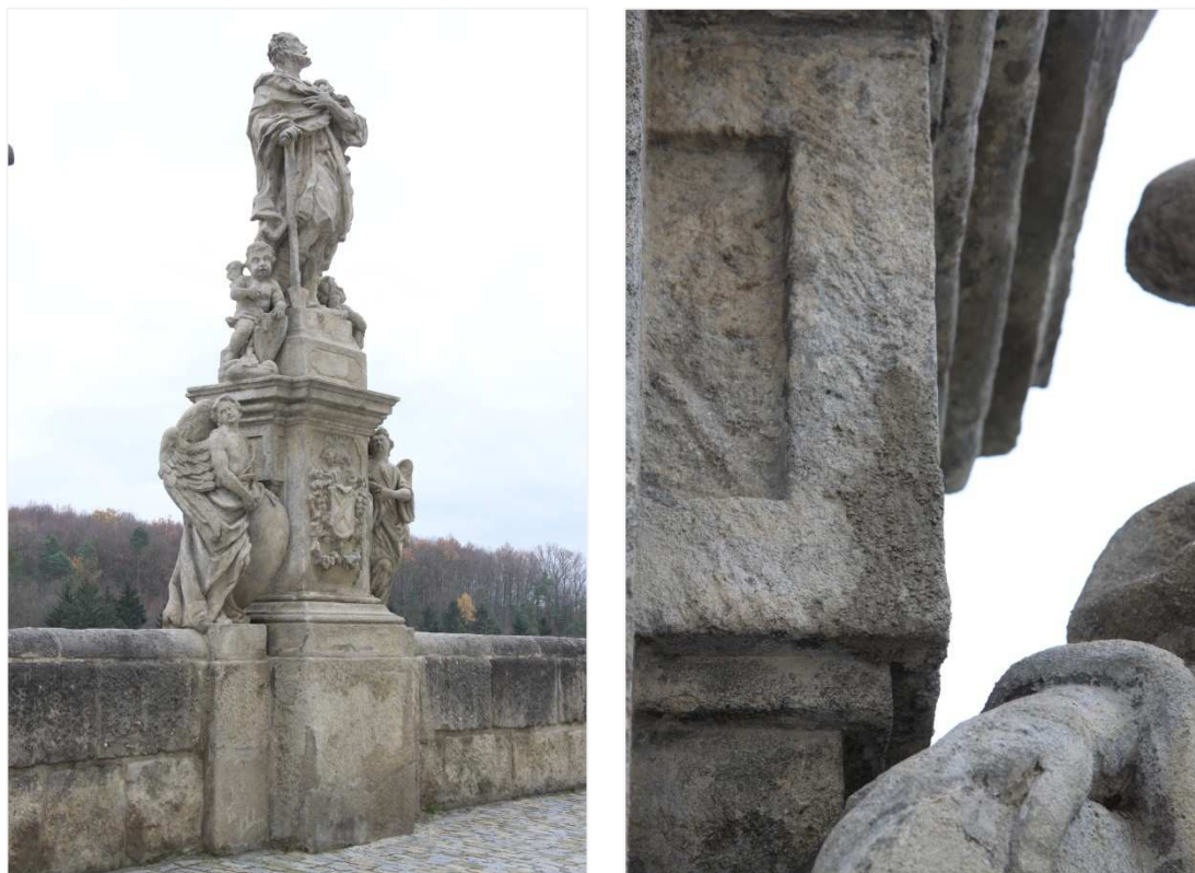
Obr. 1: Socha sv. Václava, parapetní zeď, Jezuitská kolej, Kutná Hora, materiál: kutnohorský vápenec. Restaurátorské opravy na objektu, ilustrativní foto (vpravo).
