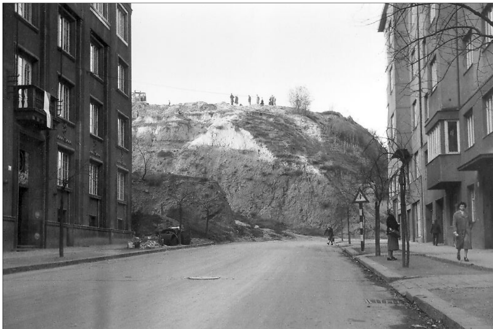
Obr. 3. Pohled z ulice Úvoz směrem ke křižovatce s Grohovou. Skalní svah před stavebními úpravami
