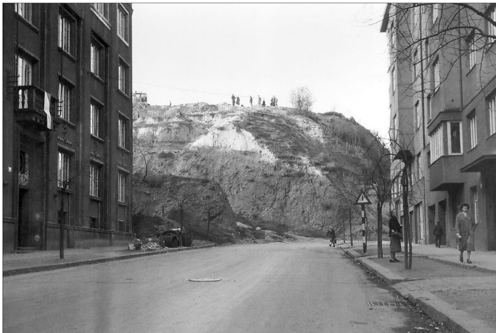
Obr. 3. Pohled z ulice Úvoz směrem ke křižovatce s Grohovou. Skalní svah před stavebními úpravami
