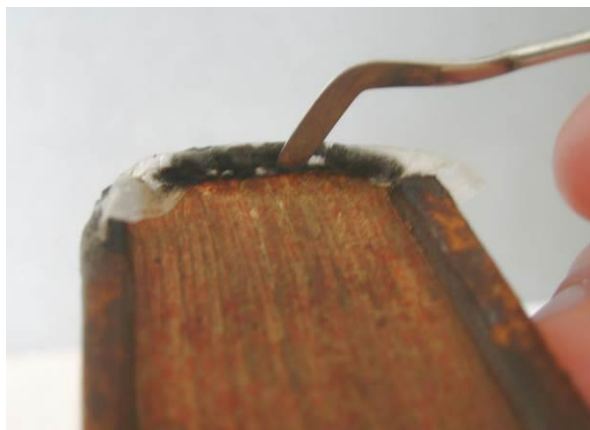
Obr. 32 /Založení, vymodelování proužku AJF pomocí kovového hladítka
