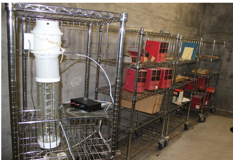
Obr. 12: Pohled do depozitáře s generátorem par EO
