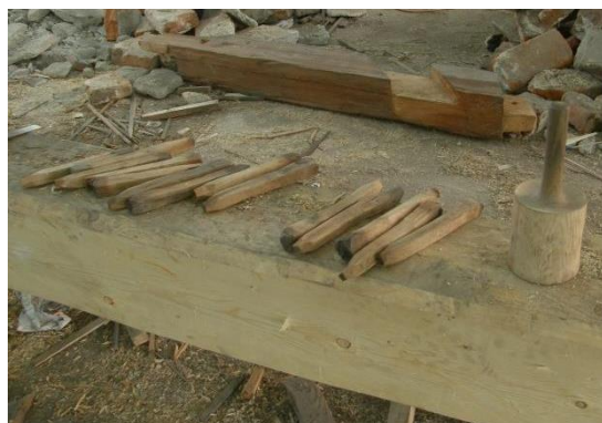
Obr. 69 Dřevěný hřeb ve spoji (vlevo), dřevěné hřeby po vyjmutí ze spoje (vpravo)
