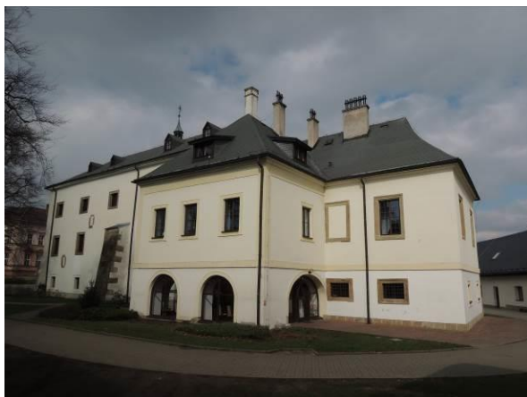
Obr. 50 Budova zámku čp. 1 na nám. A. Jiráska v Lanškrouně
