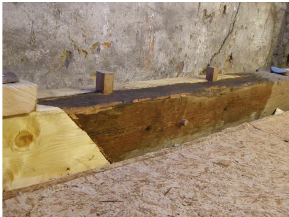
Obr. 58 Realizace nově navrženého spoje v barokním krovu zámku Lanškroun (pohled směrem na původní část vazného trámu)
