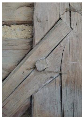
Obr. 69 Dřevěný hřeb ve spoji (vlevo), dřevěné hřeby po vyjmutí ze spoje (vpravo)
