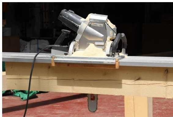
Obr. 35 Řezání podélného plátu pomocí tesařské řetězové pily
