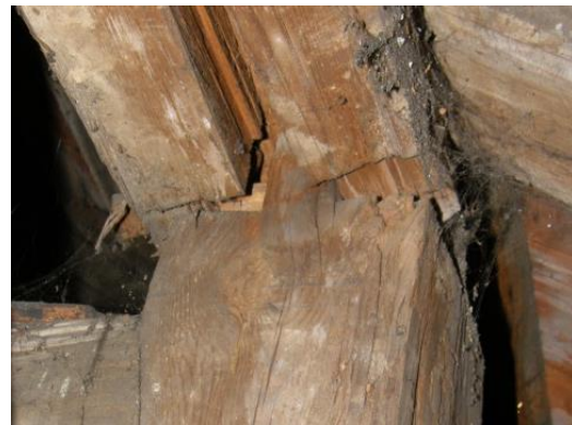
Obr. 4 Tah kolmo k vláknům
