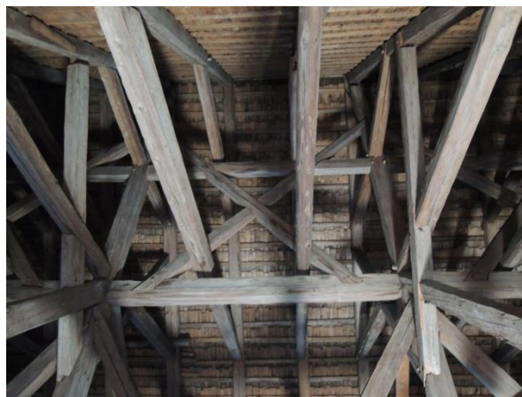
Obr. 64 Detail podélného zavětrování ve střední části barokního krovu kostela v Červené Vodě
