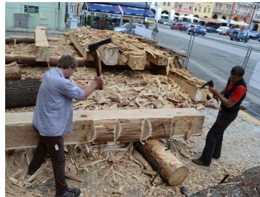
Obr. 73 Vrubování (vlevo) [28], hrubování (vpravo)
