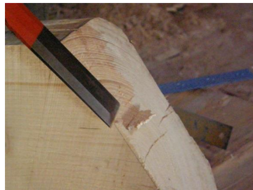
Obr. 45 Osekání nadbytečné délky plátu
