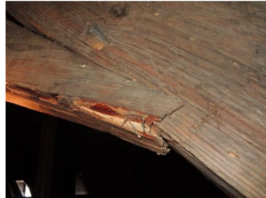
Obr. 2 Tlak šikmo k vláknům (pásek na sloupek)
