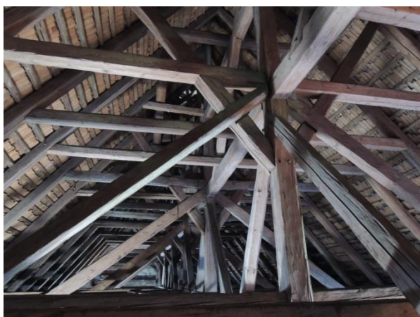
Obr. 61 Příčná vazba barokního krovu kostela v Červené Vodě
