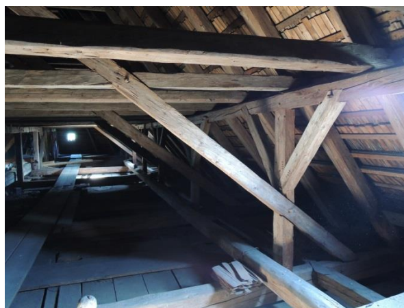
Obr. 62 Boční podélné vázání barokního krovu kostela v Červené Vodě
