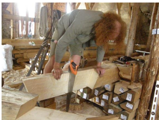
Obr. 42 Příprava drážky pro hmoždík pomocí ruční pily
