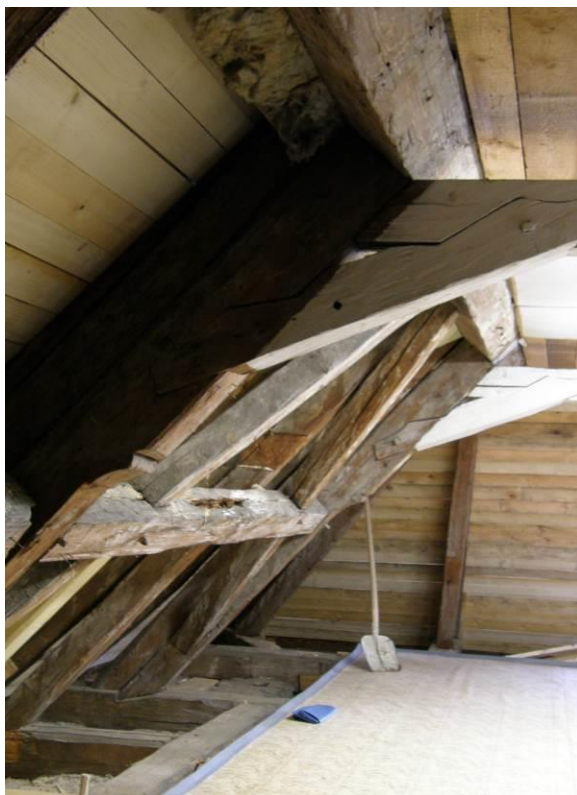
Obr. 54 Detail podélného vázání barokního krovu zámku v Lanškrouně
