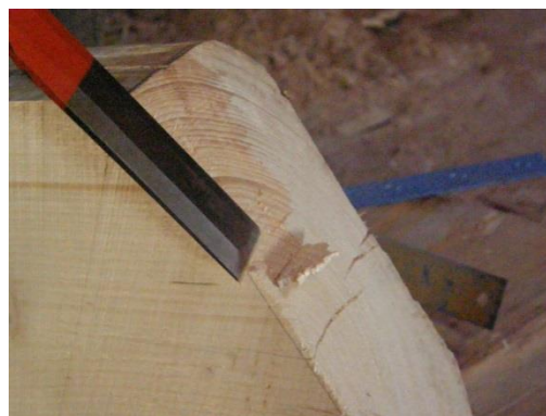
Obr. 45 Osekání nadbytečné délky plátu
