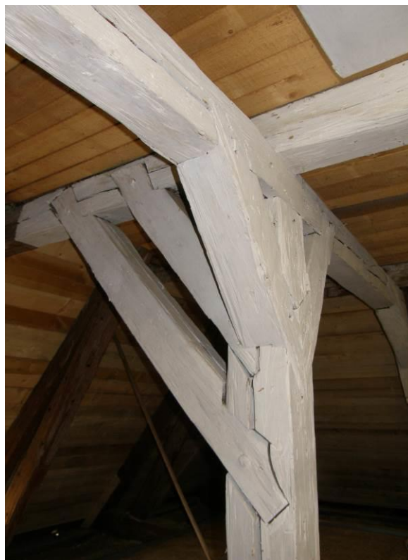
Obr. 55 Detail podélného zavětrování ve střední části barokního krovu zámku v Lanškrouně
