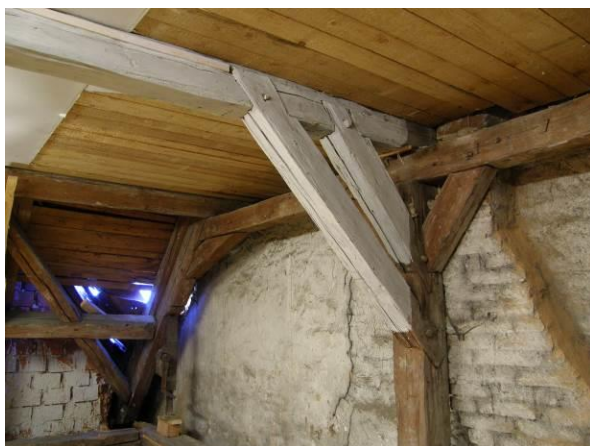
Obr. 52 Příčná vazba a podélné vázání barokního krovu zámku v Lanškrouně
