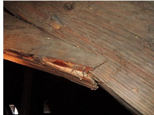
Obr. 2 Tlak šikmo k vláknům (pásek na sloupeku)
