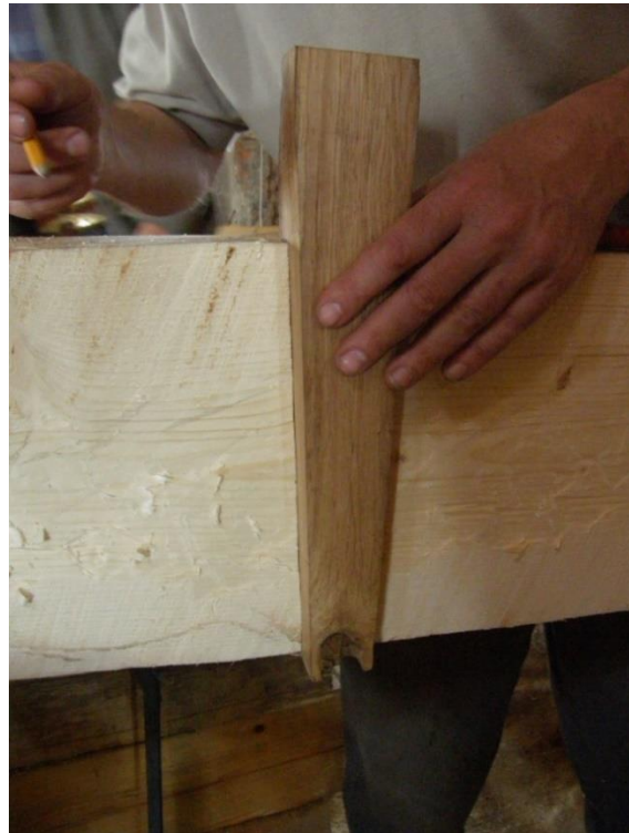
Obr. 47 a) Vyřeznutí drážek pro hmoždík s odsazením umožňujícím rozpěr čel při dotahování hmoždíku (je zvýrazněno barevně; vlevo nahoře), b) kontrola osazení hmoždíku v drážce (vpravo), c) výroba drážky pro hmoždík přímo při sesazení spoje (vlevo dole)
