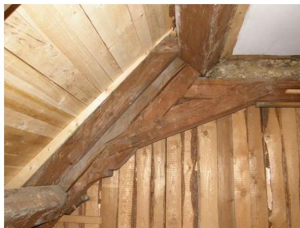
Obr. 53 Detail části příčné vazby barokního krovu zámku v Lanškrouně
