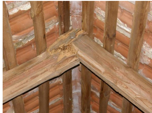
Obr. 6 Biologické napadení spoje
