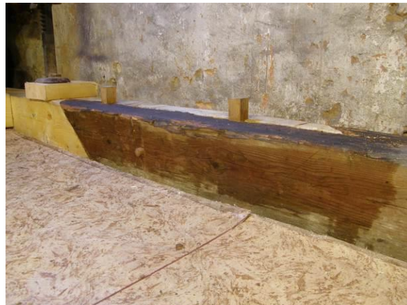
Obr. 59 Realizace nově navrženého spoje v barokním krovu zámku Lanškroun (pohled směrem na nově vkládanou část vazného trámu)
