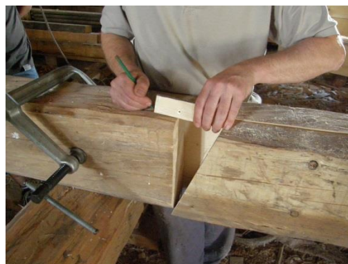
Obr. 43 Orýsování šikmého čela z již zafixovaného protikusu
