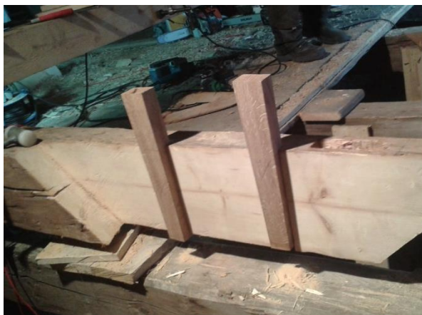
Obr. 67 Realizace nově navrženého spoje v barokním krovu kostela v Červené Vodě (pohled na přípravu spoje před sesazením)
