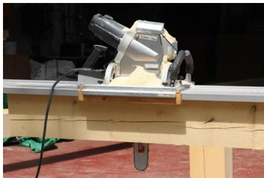
Obr. 22 Řezání podélného plátu pomocí tesařské řetězové pily
