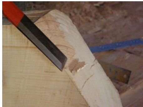
Obr. 32 Osekání nadbytečné délky plátu
