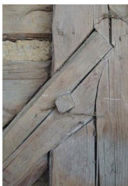
Obr. 37 Dřevěný hřeb ve spoji (vlevo), dřevěné hřeby po vyjmutí ze spoje (vpravo)
