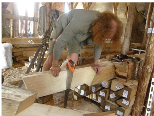
Obr. 29 Příprava drážky pro hmoždík pomocí ruční pily
