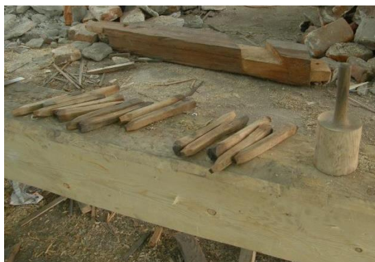
Obr. 37 Dřevěný hřeb ve spoji (vlevo), dřevěné hřeby po vyjmutí ze spoje (vpravo)
