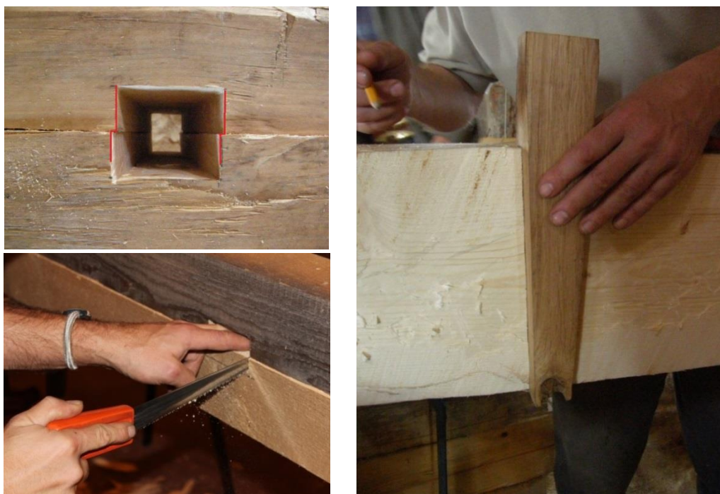
Obr. 34 a) Vyřiznutí drážek pro hmoždík s odsazením umožňujícím rozpěr čel při dotahování hmoždíku (je zvýrazněno barevně; vlevo nahoře), b) kontrola osazení hmoždíku v drážce (vpravo), c) výroba drážky pro hmoždík přímo při sesazení spoje (vlevo dole)
