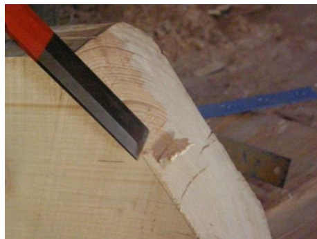
Obr. 32 Osekání nadbytečné délky plátu
