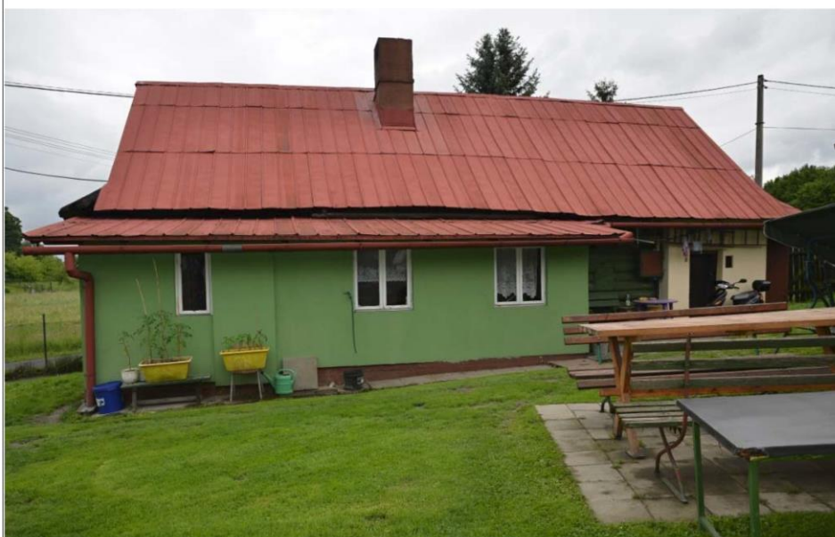
Obr. 07 Západní průčelí domu č. p. 81 s přístavbou. Foto J. Koudelová, 2014.
