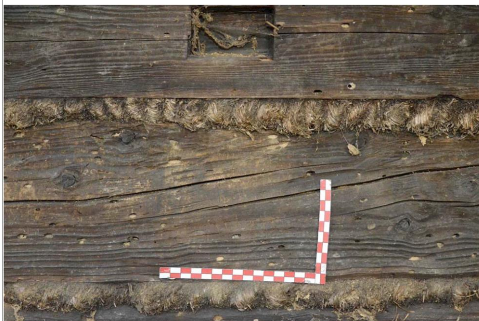
Obr. 06 Výplně spár mezi trámy roubení stodoly u č. p. 1003. Foto O. Schejbal, 2013.
