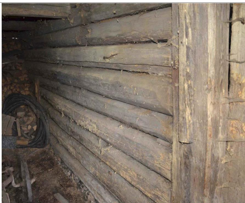
Obr. 05 Vnitřní východní roubená stěna komory stodoly u č. p. 1003. Foto O. Schejbal, 2013.
