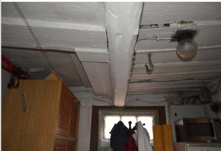
Obr. 04 Trámový záklopový strop v síni domu č. p. 81. Foto J. Koudelová, 2014.
