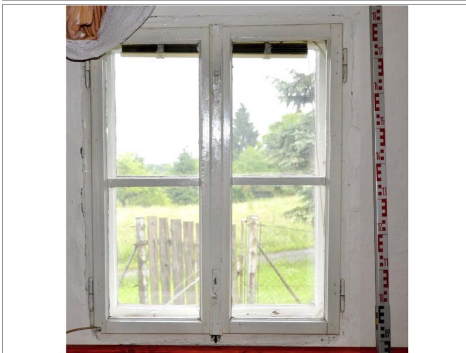
Obr. 05 Vnitřní okenní křídla v menší světnici domu č. p. 81. Foto J. Koudelová, 2014.
