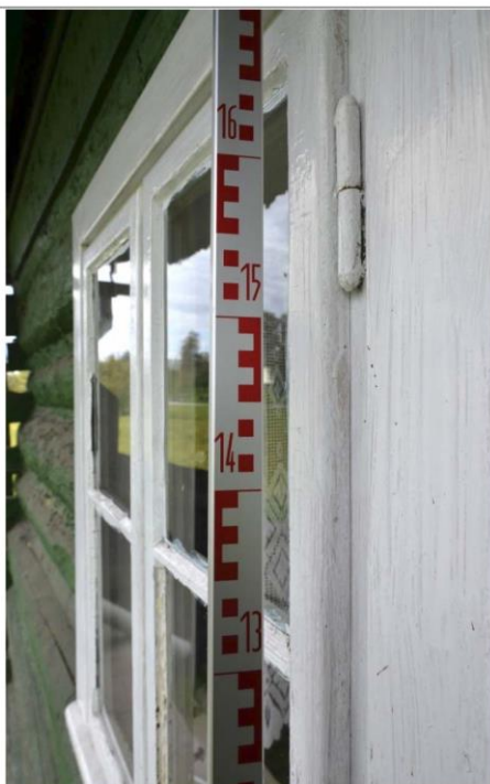
Obr. 03 Detail okna v severním průčelí domu č. p. 81. Foto J. Koudelová, 2013.
