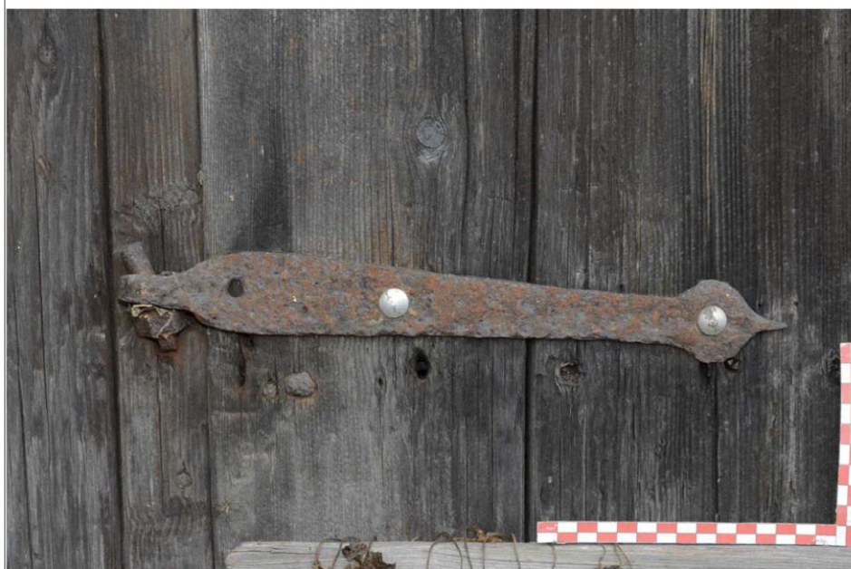
Obr. 06 Vodorovný závěs u dveří v jižním průčelí stodoly u č. p. 1003. Foto O. Schejbal, 2013.
