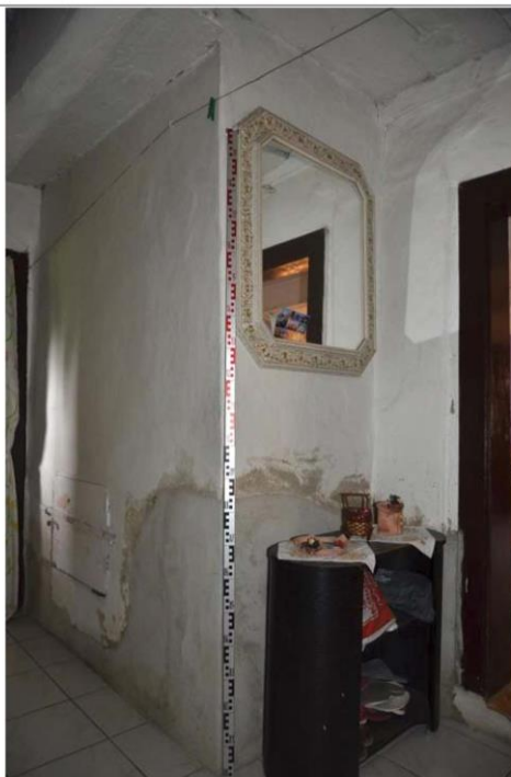
Obr. 02 Kominové těleso v síni domu č. p. 81. Foto J. Koudelová, 2014.
