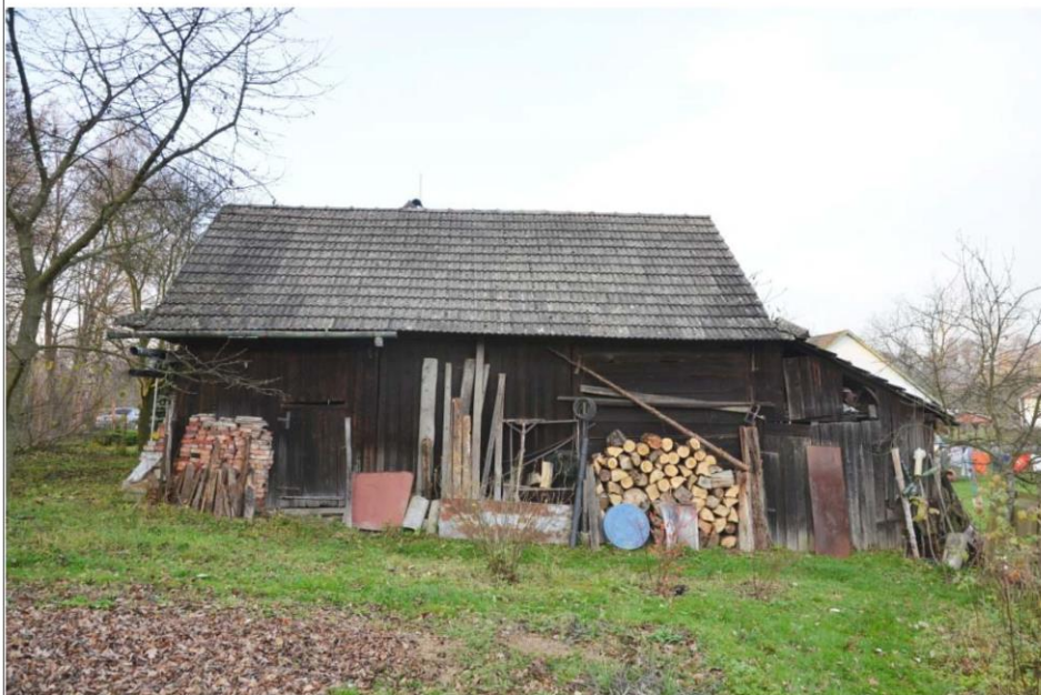
Obr. 06 Jižní průčelí stodoly u č. p. 1003. Foto O. Schejbal, 2013.
