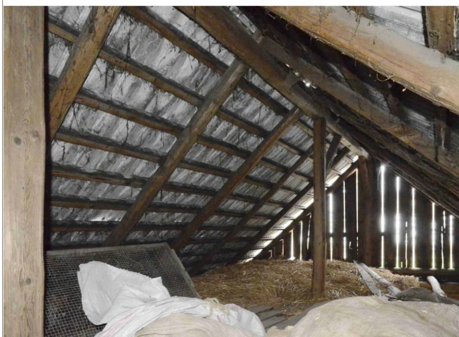
Obr. 05 Pohled do krovu stodoly u č. p. 1003 od severozápadu. Foto O. Schejbal, 2013.
