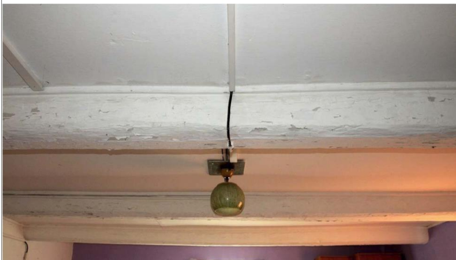
Obr. 03 Trémový strop s novodobým pohledem mezi stropnicemi v prostoru větší světnice domu č. p. 81. Foto J. Koudelová, 2014.
