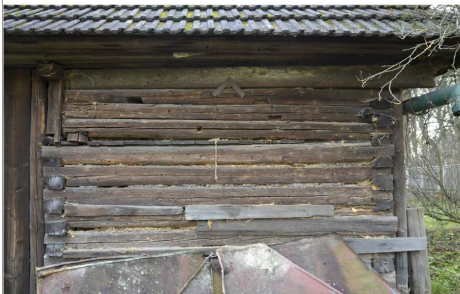
Obr. 02 Roubená část severního průčelí stodoly u č. p. 1003. Foto O. Schejbal, 2013.
