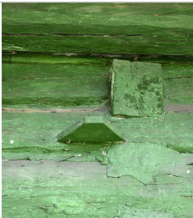
Obr. 04 Zarážka na východní roubené stěně, zabraňující rámu s pletivem/sítí narážet do roubení. Foto J. Koudelová, 2013.
