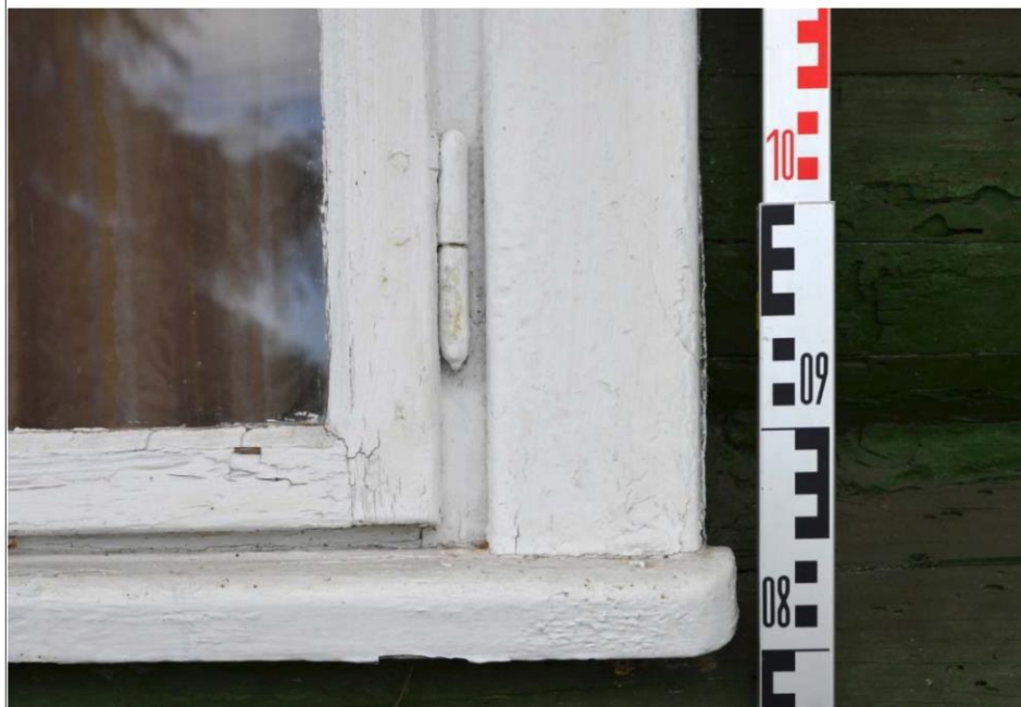
Obr. 04 Detail okna – závěs a parapet – ve východním průčelí domu č. p. 81. Foto J. Koudelová, 2013.
