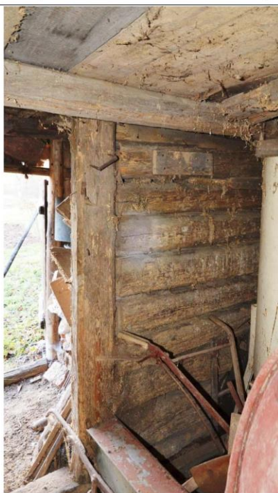
Obr. 04 Krátký úsek jižní stěny roubené komory stodoly u č. p. 1003. Foto O. Schejbal, 2013.
