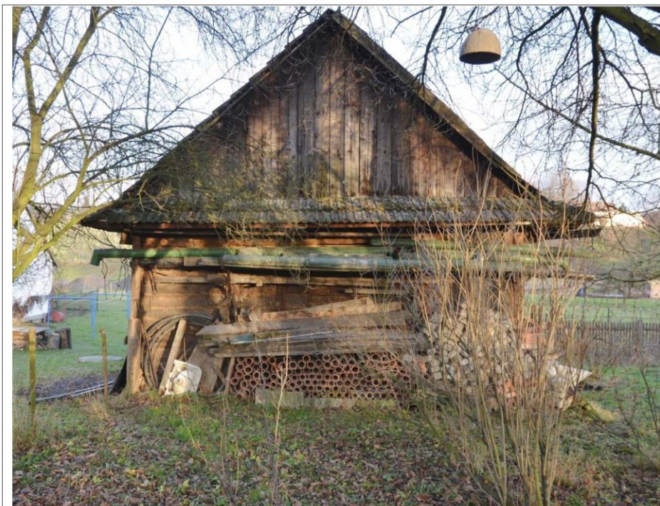
Obr. 07 Západní štítové průčelí stodoly u č. p. 1003. Foto O. Schejbal, 2013.
