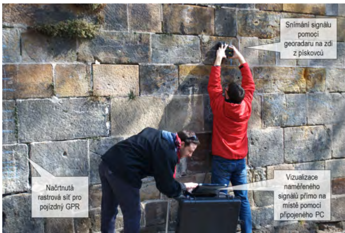
Obrázek 17: Vlastní proces měření GPR anténou na pískovcové zdi
