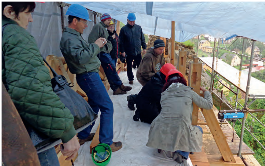
Obr. 66. Při závěrečné tesařské dílně nazvané „Jak se staví most“ se účastníci podíleli na osazení boční konstrukce zábradlí a tím také na celkovém dokončení stavby parkánové lávky u západní paty bečovského donjonu (foto D. Wizovská).
