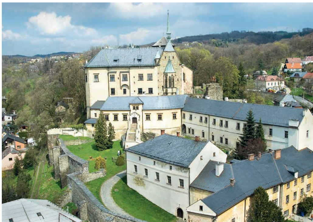
Obr. 58. Hrad Šternberk (foto archiv NPÚ)
