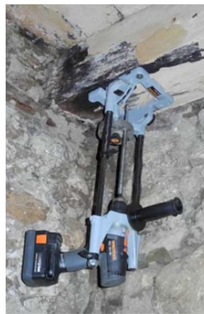
Obr. 2 Speciální stojánek pro upevnění vrtačky s vrtákem a ukotvení k prvku
