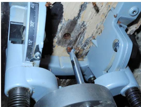
Obr. 1 Detail frézovacího vrtáku pro přípravu vrtu prům. 12 mm
