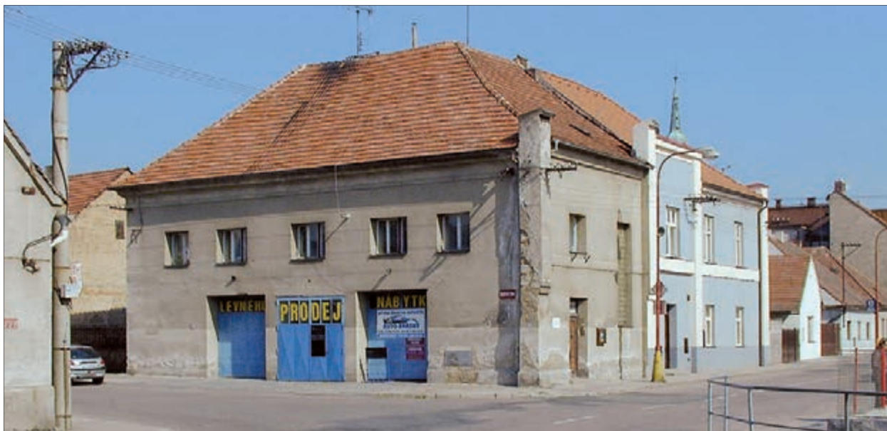
Příklady zásadního narušení fasád staveb kategorie A či H.
