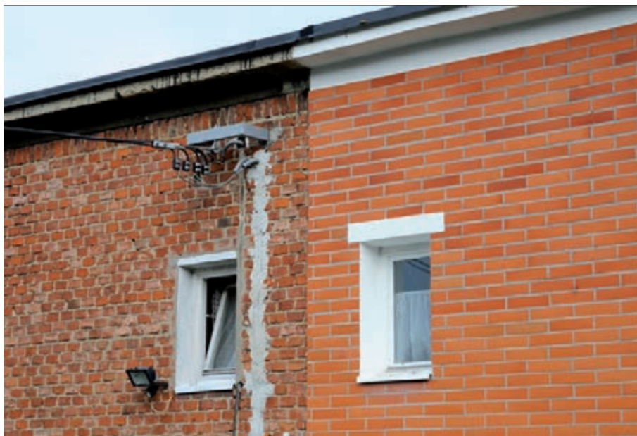
Rozdíl originální režné fasády a obkladu keramickými pásky vyniká zvláště při detailním pohledu.
