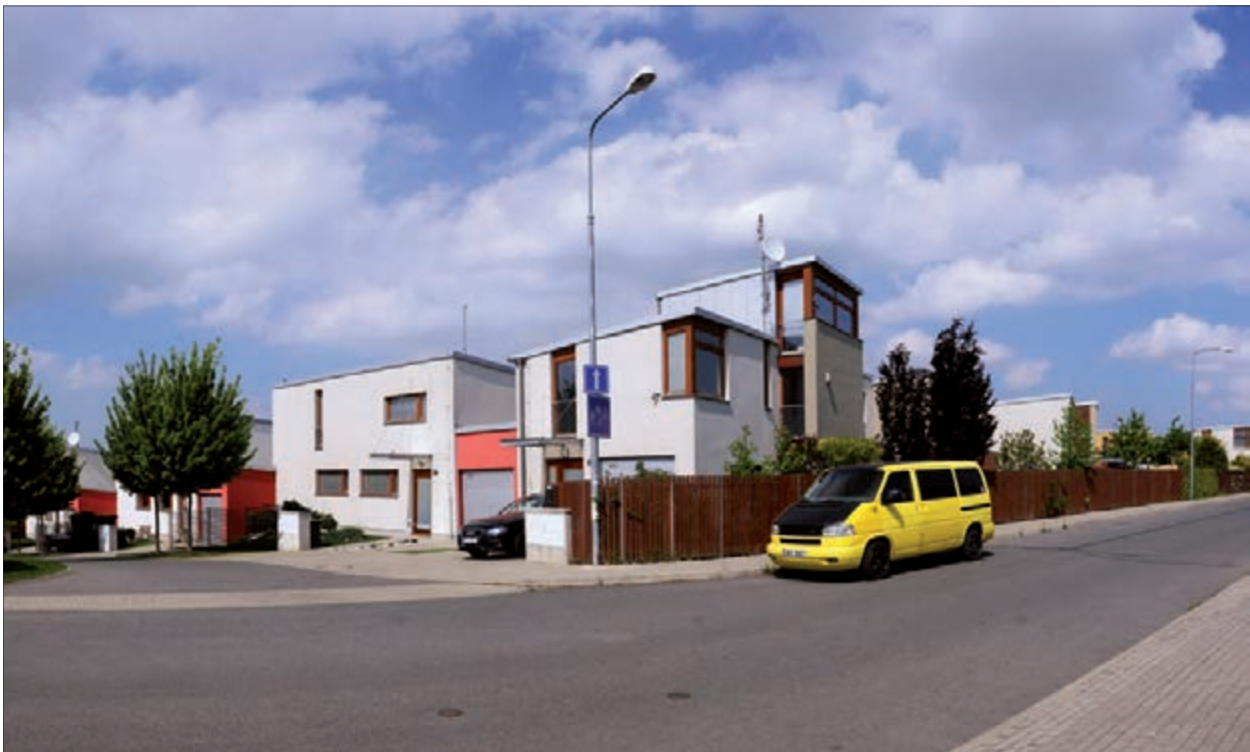
Architektonicky cenné novostavby v kontextu koncepčně vybudovaných nových urbanistických celků
