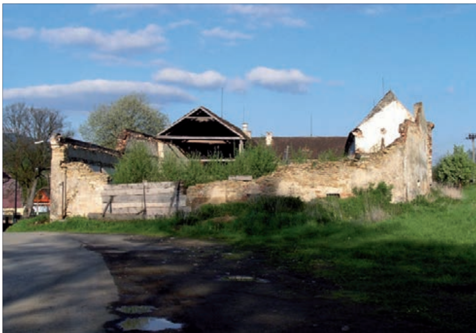
Příklad torzální stavby, z níž zůstaly jen obvodové zdi.
