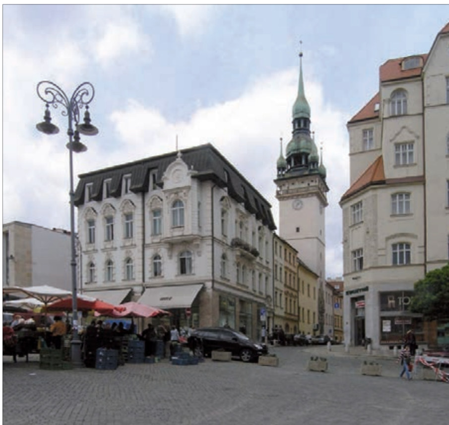
Atypický případ, kdy došlo k záměrnému podstatnému snížení nárožního domu, aby nekonkuroval věži radnice a sousední nižší novostavbě. Dům byl nově završen pseudomansardovou střechou, jejíž tupé proporce charakter prostředí výrazně poškozují.
