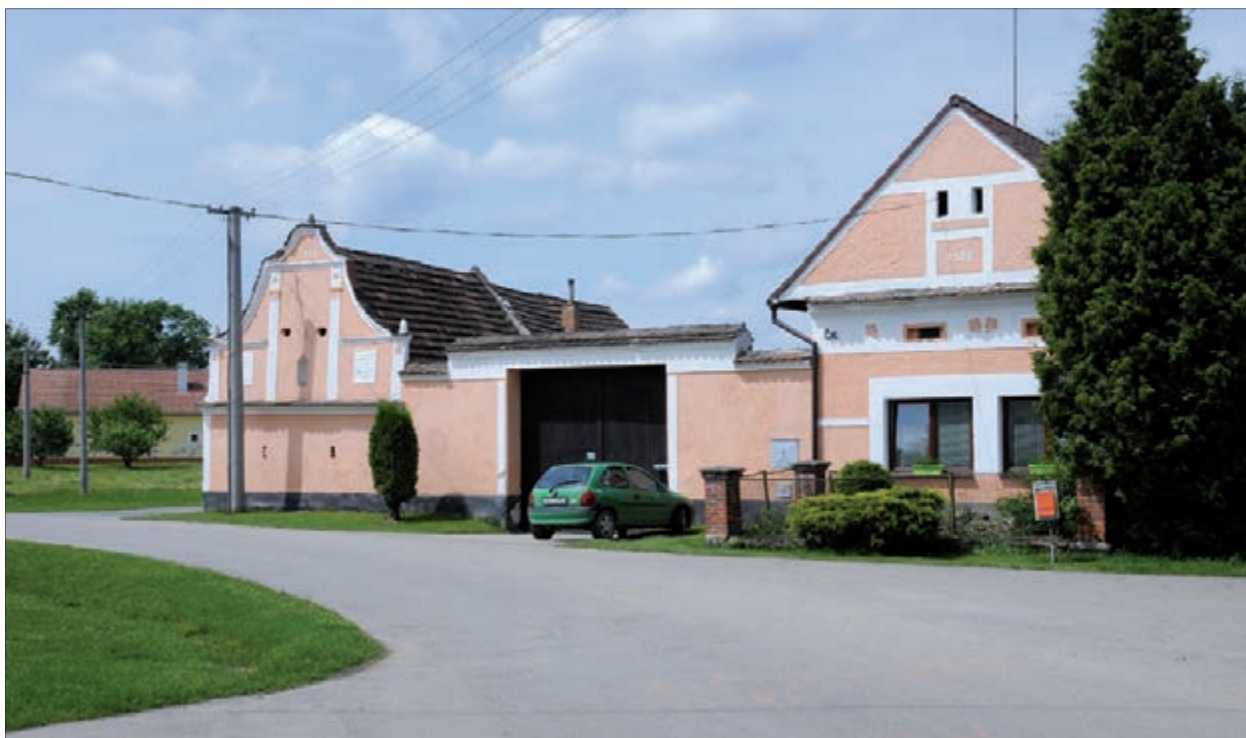
Částečné narušení fasád osazením typových oken větších rozměrů, v důsledku čehož zaniklo též architektonické členění okolních ploch průčelí.
