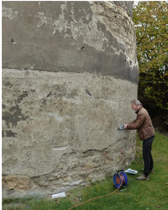
Obr. 12. Odběr vzorků pro pevnostní zkoušky a zjištění pórovitosti omítky
