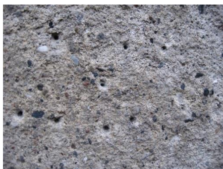
Obr. 16 b. Detail omítky na zkušební ploše REF 1 po 10 vrtech
