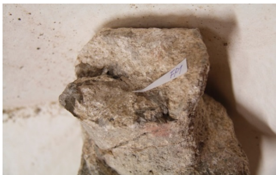
Místo měření FP1- degradovaný povrch
