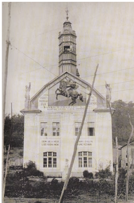
Obr. 11. Fotografie průčelí dvoru Vladimírov z roku 1902.
