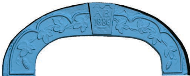
Obr. 30. Export dat nasnímaných HandySkenem do uživatelského prostředí Adobe, 3D ve formátu *.pdf, který umožňuje základní prohlížení, otáčení, zoomování, provádění řezů, změnu úhlu a typu osvětlení. Reliéf v nadpraží portálu, Heřmánkovice č. p. 44. Sken a zpracování Michal Trněný.
