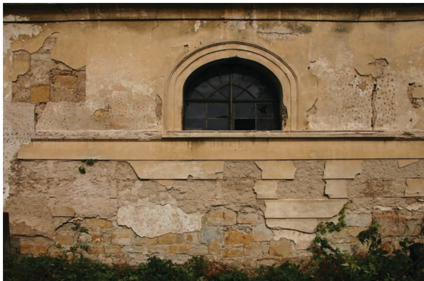
Obr. 8. Černěves, kostel sv. Prokopa, jižní průčelí lodi, v soklové části se v místě opadajících empírových omítek projevuje struktura románského zdiva lodi, při západní hraně je v horní části patrný zazděný románský okenní otvor. Foto: Táňa Nejezchlebová, 2009.
