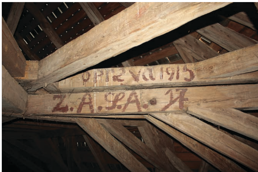
Obr. 28. Telce, kostel sv. Mikuláše – datace v krovu svědčící o jeho opravě na počátku 20. století. Foto: Lucie Radová, 2011.
