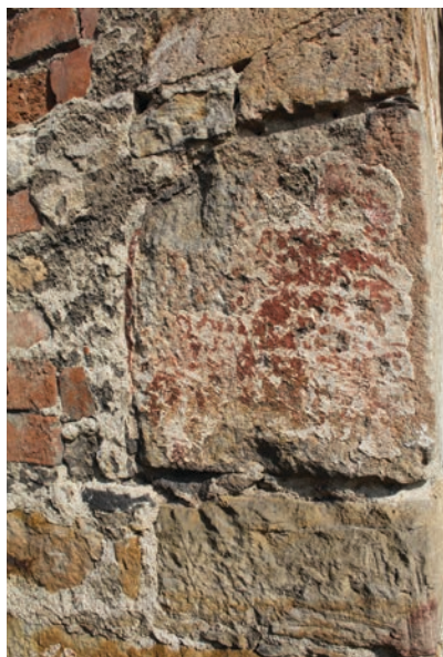
Obr. 9. Přechápy, kostel sv. Matouše, relikty historické barevnosti na nárožních kvádrech. Foto: Vít Honys, 2012.
