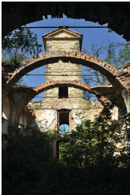
Obr. 17. Encovany – Prachová, kaple sv. Václava, z klenby lodi se dochovaly pouze meziklenební pasy a koutové náběhy nasazené na přízdní pilastry. Foto: Táňa Nejezchlebová, 2012.
