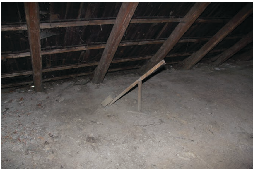
Obr. 30. Minice, kostel sv. Martina – detail závěsného zařízení (kladky) v prostoru krovu nad severním bočním oltářem k zavěšení lampy na věčné světlo. Foto: Lucie Radová, 2008.
