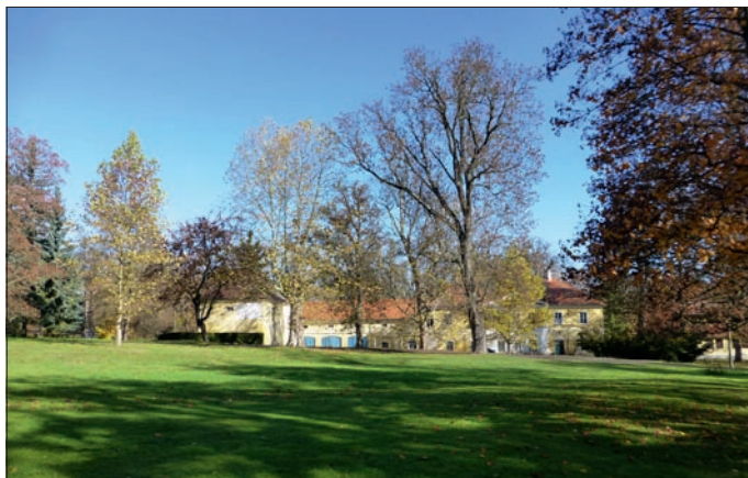
Čimelice, torz, kočár- rova a tzv. Zámeček uzavírající severní stranu čestného dvora východně od zámku. Souřadnice stano- viště N 49.46694, E 14.06567. Marie Paolátová, Ing., 2013-10-24
