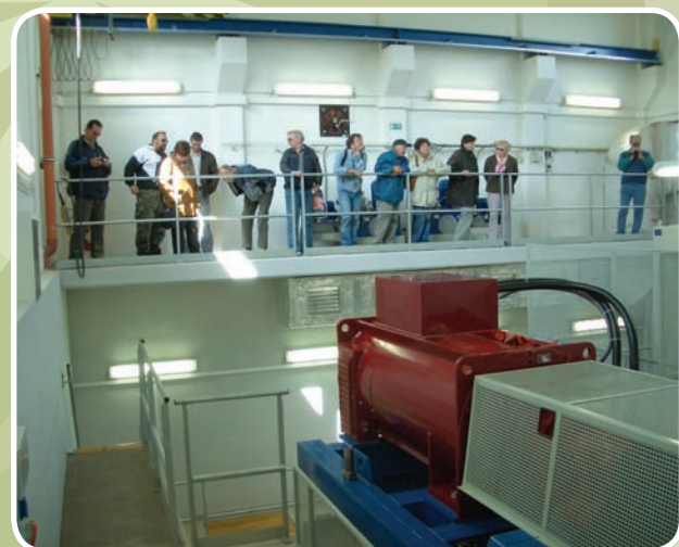
Den otevřených dveří malé vodní elektrárny u Libočan – exkurzi zajistila pro 211 zájemců žatecká pobočka Ekodomova.
