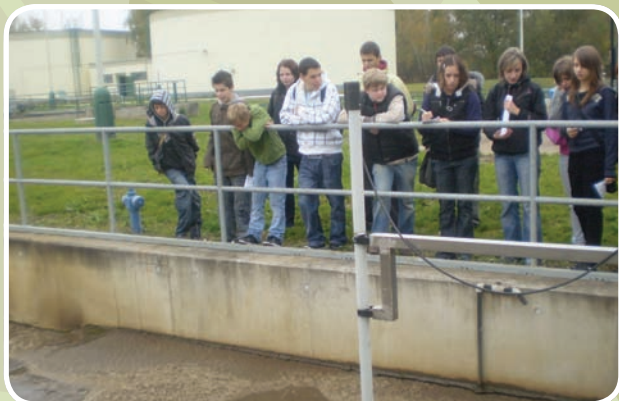
Čistírna odpadních vod
