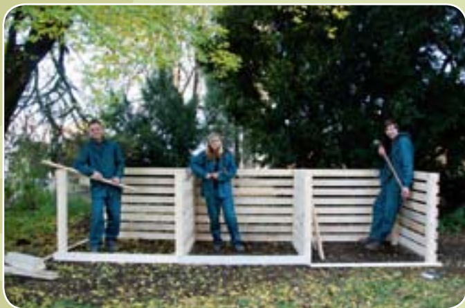
Stavba kompostéru na SZeŠ v Benešově
