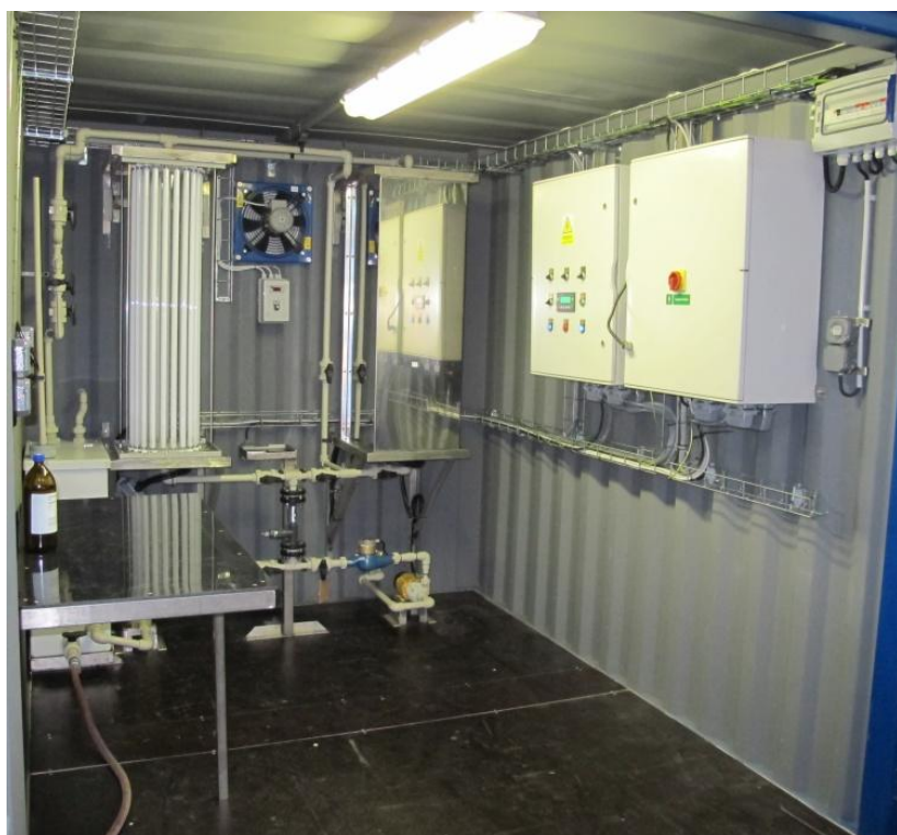
Obr. 1 Vlevo uspořádání jednotky fotochemické oxidace H_2O_2/UVC v podobě mobilní dekontaminační stanice.
