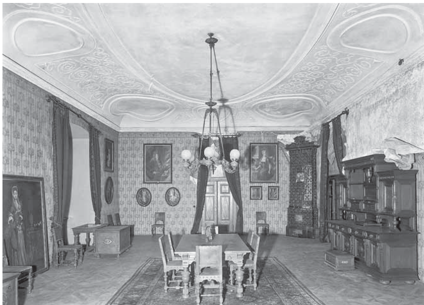
Obr. 1. Doudleby nad Orlicí (okres Rychnov nad Kněžnou), zámek. Vlhčí vzduch je lehčí. Destrukce tapet vpravo pod stropem jako doklad přítomnosti lehčího vlhkého vzduchu při velmi nízké teplotě. Zámek byl v roce 1949, v den pohřbu Michaela hraběte Bubna-Litic, zabrán původním majitelům, uzavřen a úředně zapečetěn. 2 V důsledku nevětrání a netemperování místností došlo v letech 1949–1950 k poškozením. (Foto Čestmír Šíla, 1950)
