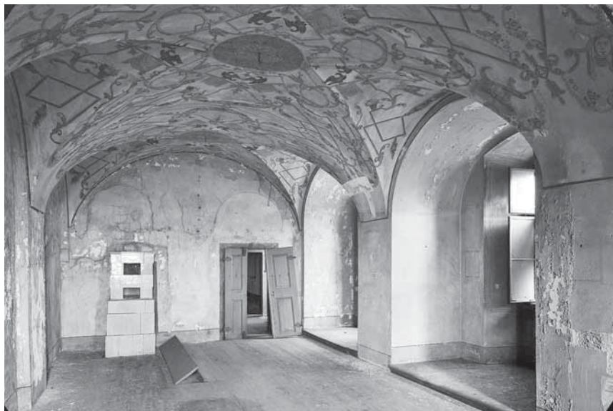
Obr. 13. Jezeří (okres Most), zámek, takzvaný lovecký salón. Stopy tepelné radiace se projevují na stěně za kamny, zatímco teplotní proudění ovlivní povrchy nad kamny (viz též obrázek 35, zámek Doudleby nad Orlicí, sál s bílými kamny). (Foto Vladimír Hyhlík, 1967)
