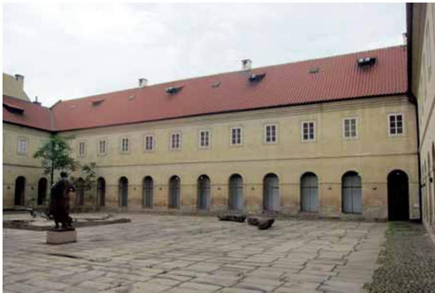
Obr. 29. Cirkulace vzduchu na velkém uzavřeném nádvoří nezpůsobuje díky vlivu poměru jeho šířky k výšce tak rozsáhlá poškození jako v případě malých uzavřených nádvoří. I v těchto případech je nutné, jako jeden z podkladů pro úspěch rekonstrukce, dokumentovat všechny stopy způsobené cirkulací vzduchu. (Foto Milan Jančo, 2011)
