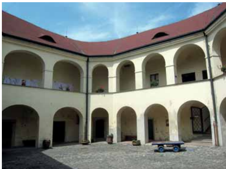
Obr. 26, 27. Poškození na osluněném úpatí severního traktu nádvoří je typické pro malá uzavřená nádvoří. Před zahájením obnovy je nutné dokumentovat stopy po poškození způsobené cirkulací vzduchu a jejich rozsahu přizpůsobit zvolený způsob povrchového ošetření fasád. I když je fasáda památkového objektu nově obnovená, nelze v těch samých místech zabránit jejímu opakovanému poškození, k tomu dochází působením stále cirkulace vzduchu. (Foto Vladimír Fyman 1956; Milan Jančo, 2011)
