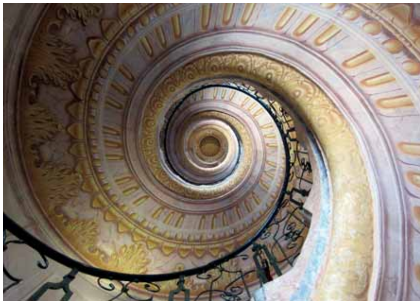
Obr. 31. Schodiště vysoké budovy s netěsnými okny se chová stejně jako otevřený komín. I v něm „platí“ komínový efekt. (Foto Milan Jančo, 2011)
