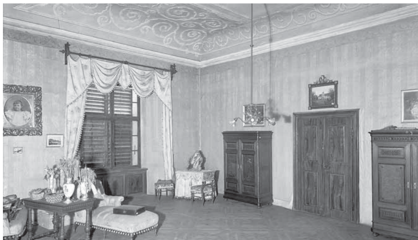
Obr. 41. Doudleby nad Orlicí (okres Rychnov nad Kněžnou), zámek. Špaletové okno chráněné zvenčí dřevěnými žaluziemi. Žaluzie umístěné na západní a východní straně zabraňovaly v letním období nadměrnému přehřívání se interiéru, jak po ránu, tak především na večer. Žaluzie na jižní straně objektu chránily interiéry zejména v zimním období, kdy nízké slunce během poledne pronikalo hluboko do místností. (Foto Čestmír Šíla, 1950)
