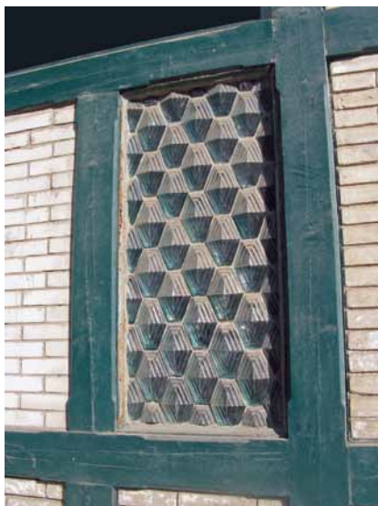
Obr. 9: K památkově hodnotným výplním okenních otvorů patří i mnohá okna ze sklobetonových tvárnic (Roztoky – okres Praha-západ, nádraží; foto A. Schubert, 2014).
