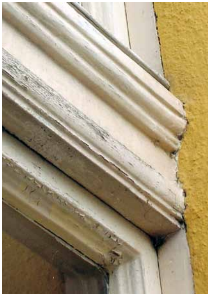
Obr. 29: Ukázka fotografické dokumentace profilace poutce vnějšího okna (Toužim – okres Karlovy Vary, dům čp. 104; foto A. Schubert, 2010).
