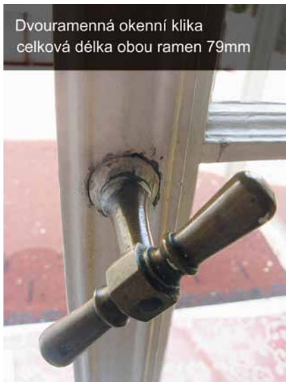
Obr. 34: Údaj o rozměru fotografovaných prvků a jejich součástí je možné vložit přímo do fotografie (Vojkov – okres Benešov, zámek; foto A. Schuber, 2013).
