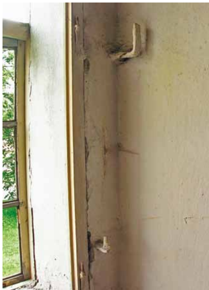
Obr. 7: Při prohlídce zkoumané stavby je nutné věnovat pozornost i pozůstatkům odstraněných výplní okenních otvorů. V tomto případě jde o osazovací rám vnitřního okna, stěžež závěsu okenice a hák pro osazení závory (Toužim – okres Karlovy Vary, zámek; foto A. Schubert, 2010).
