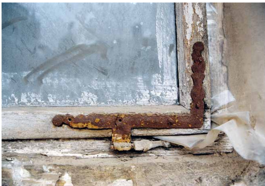
A11: Detail rohovníkového závěsu (rozměry viz kresba A7 s měřítkem).
