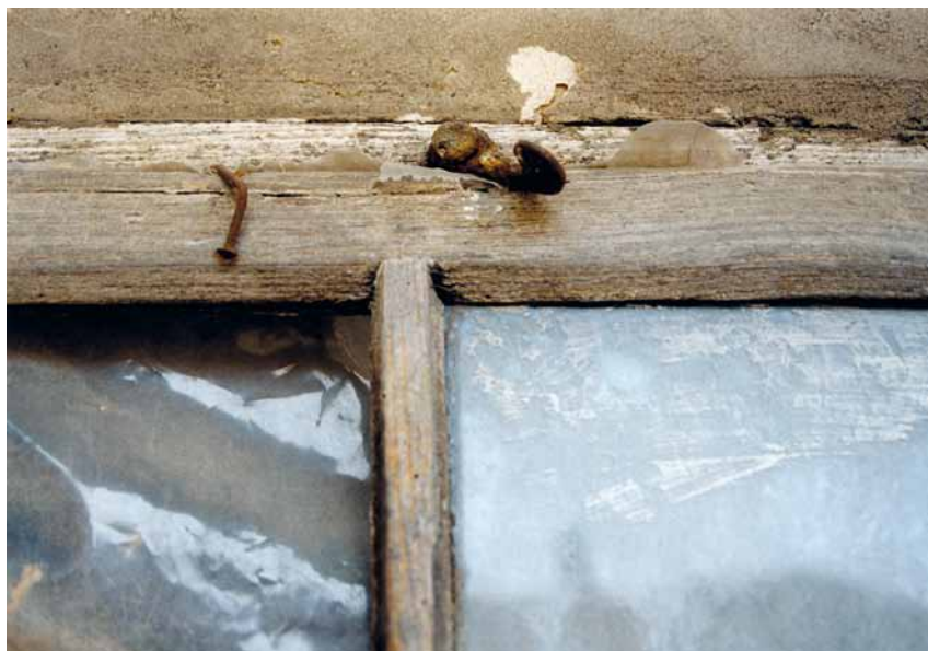
A9: Detail obrtlíku (rozměry viz kresba A7 s měřítkem).
