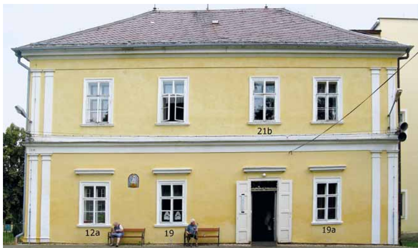
Obr. 21: Dokumentovaná okna lze rovněž vyznačit ve fotografii fasády (Vojkov – okres Benešov, zámek; foto A. Schubert, 2013).
