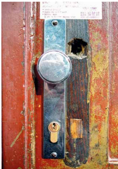
Obr. 18: Pod odstraněným starším štítkem zůstal zachován původní fládrový nátěr dveřních křídel. Při nejbližší opravě bude překryt novým nátěrem, proto je nutné náleznout bez odkladu dokumentovat (Praha 3 - Žižkov, dům čp. 1247; foto A. Schubert, 2006).
