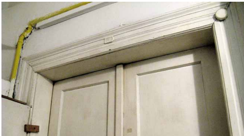
Obr. 8: Profilované obložení svědčí o tom, že novější dveřní křídla jsou osazena do původní zárubně (Praha 2 - Vinohrady, dům čp. 1120; foto A. Schubert, 2014).
