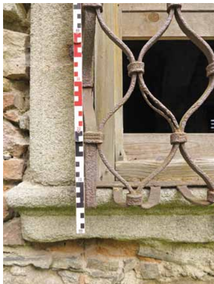
Obr. 33: Detail spínané okenní mříže s přiloženým měřidlem (Horní Slavkov – okres Sokolov, děkanství čp. 178; foto J. Chaloupka, 2014).
