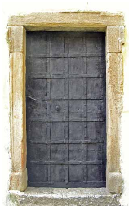
Obr. 14: U kovových dveří, případně okenic, je nutné popsat, zda jsou sestaveny ze součástí vykovaných z kujného železa, nebo z válcovaného materiálu (Stříbro – okres Tachov, kostel Všech svatých; foto A. Schubert, 2009).
