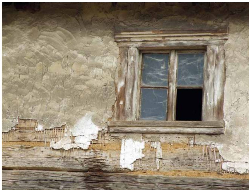
Obr. 3a, 3b: Zchátralý roubený dům z 18. století je jednou z památkově hodnotných staveb, které se nepodařilo zachránit. V rámci dokumentace objektu byla věnována pozornost i zajímavě řešenému oknu (Kralovice – okres Plzeň-sever, čp. 170; foto J. Chaloupka, 2008).
