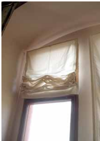
Obr. 3. Zákupy (okres Česká Lípa), zámek. Plně funkční jednoduché plátěné rolety účelně nahrazující nedochované originály. Upevnění plátěných rolet na dřevěnou lať.
