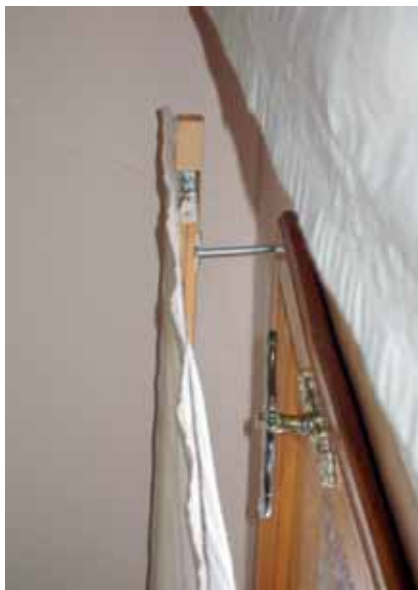
Obr. 3. Zákupy (okres Česká Lípa), zámek. Plně funkční jednoduché plátěné rolety účelně nahrazující nedochované originály. Upevnění plátěných rolet na dřevěnou lať.
