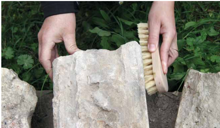
Obr. 2: Před vlastní dokumentací je nutné prvky zbavit odstranitelných nečistot, hlíny, malt apod., ale takovým způsobem (srov. pozn. 4), aby nedošlo k poškození povrchových vrstev materiálu a případných vrstev nátěrů (foto F. R. Václavík, 2012).
