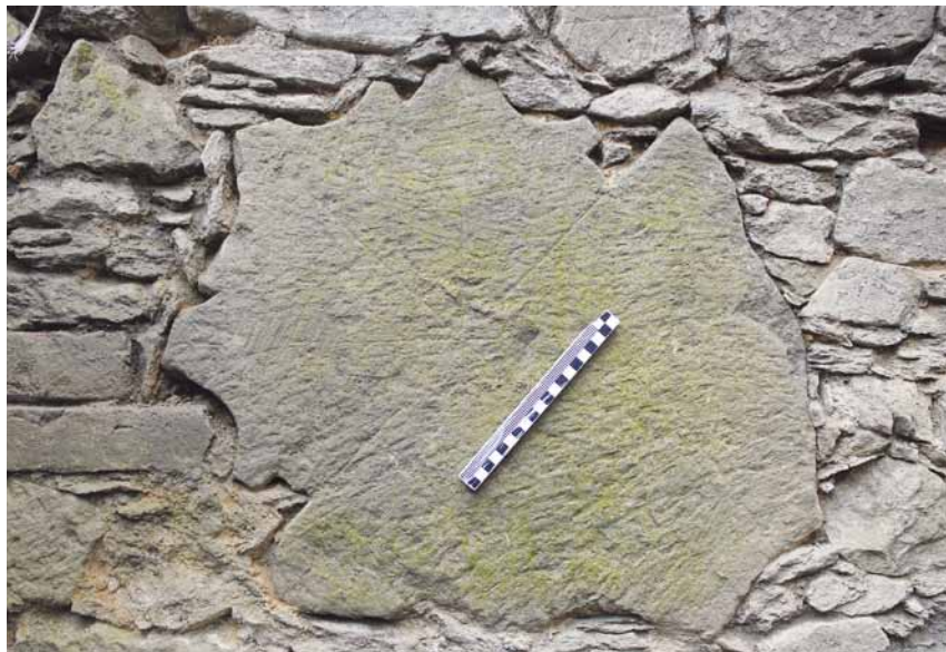
Obr. 10: Na ložné ploše druhotně zalděného prvku jsou dobře patrné osové rysky, které sloužily při rozměřování jeho tvaru (Teplá – okres Cheb, klášterní prelatura; foto M. Panáček, 2014).
