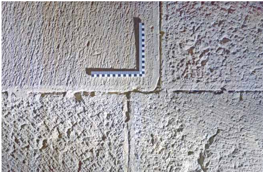
Obr. 9: Fotodokumentace stop historických kamenických nástrojů. Při bočním osvětlení je povrchová textura nejzřetelnější (Teplá – okres Cheb, kostel Zvěstování Páně; foto M. Panáček, 2014).
