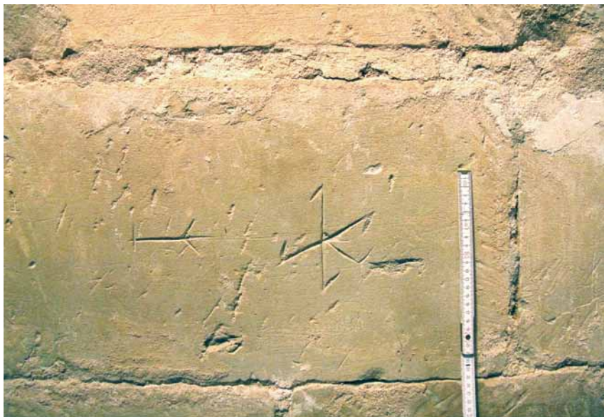
Obr. 11: Fotodokumentace kamenických značek na hlazeném povrchu pískovcového kvádru je poměrně jednoduchá. Složitějším úkolem je dokumentace mělkých, erodovaných značek na hrubém členitém povrchu při denním osvětlení (Charvátce – okres Litoměřice, věž kostela Nanebevzetí Panny Marie; foto F. R. Václavík, 2013).
