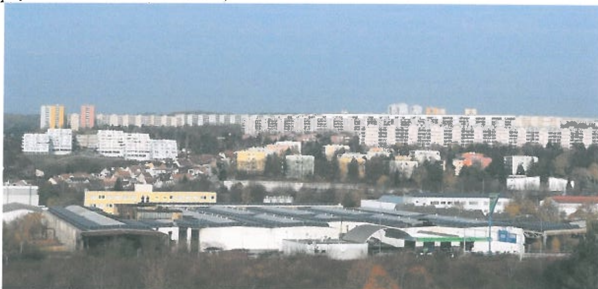
Obr. 5: Příklad solární elektrárny umístěné na střechách budov z městské části Brno-sever (v pozadí Divišova čtvrť a sídliště Lesná)
