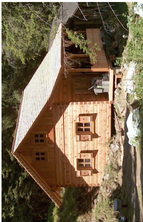
Roubený objekt z douglasky v Alpách – stav po 1. zimě, povrchová úprava – lněná fermez.
