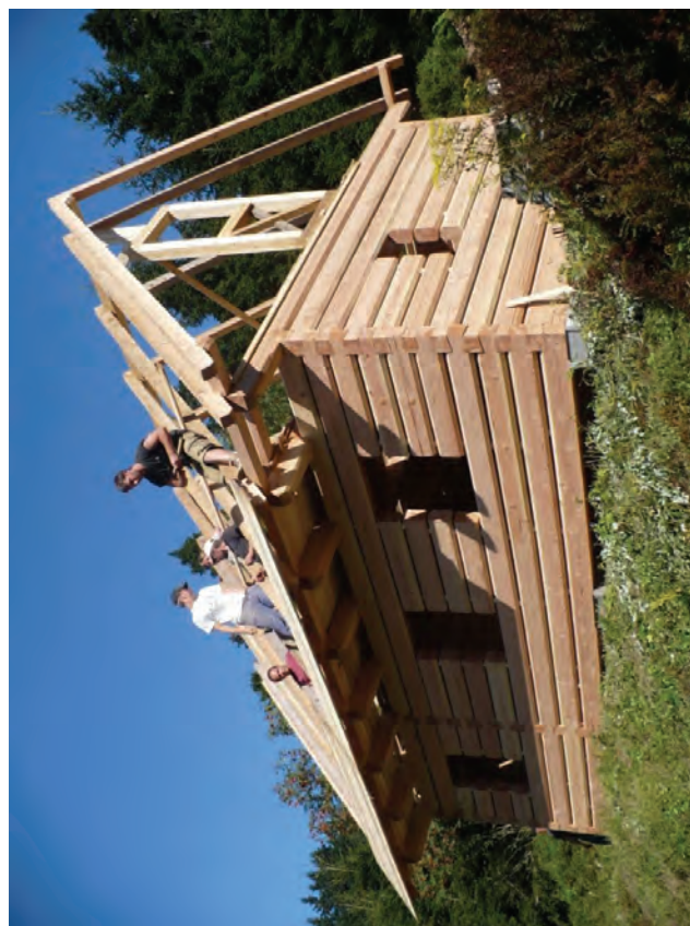
Výstavba roubeného objektu z douglasky, pokračování prací.
