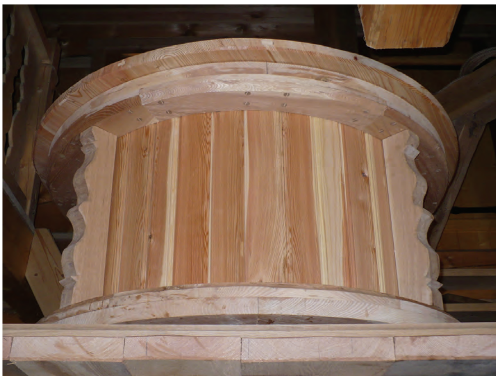
Lub mlýnského složení v obnovovaném vodním mlýně v Podorlickém skanzenu v Krňovicích (nosné prvky jsou dubové, obklad a krycí deska jsou douglaskové). Vše je bez povrchové úpravy.
