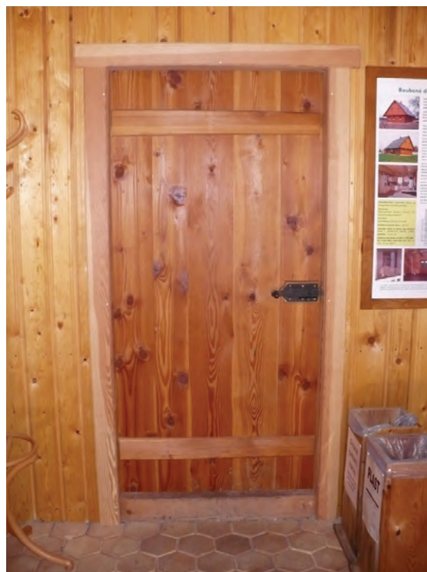
Svlakové dveře z douglasky, dobře patrná je sukovitost dřeva, povrchová úprava – lněná fermež.
