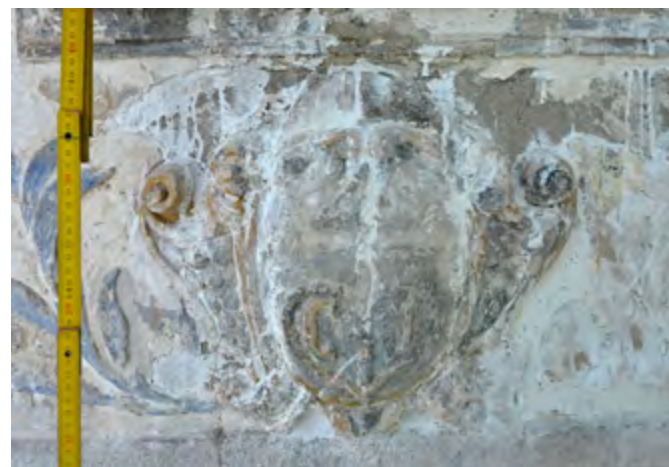
Detail měšťanské merky na domě č. p. 23 v Příboře během obnovy hlavního průčelí. Foto: J. Koudelová.
