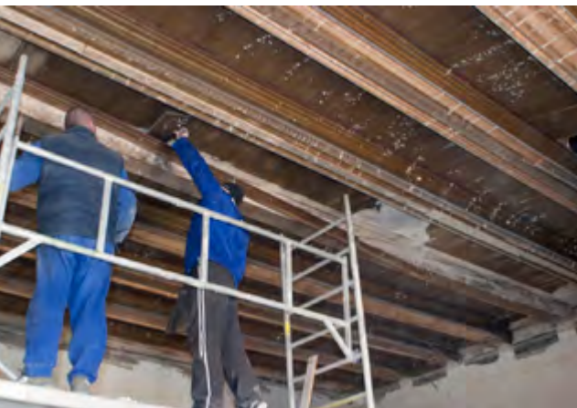
Deinstalace původního dřevěného stropu v badatelně. Foto: Archiv SZM.
