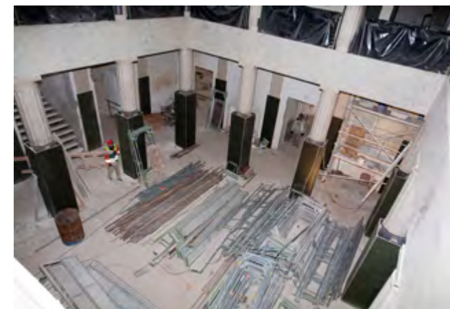
Dvorana Historické výstavní budovy v průběhu rekonstrukce. Foto: Archiv SZM.
