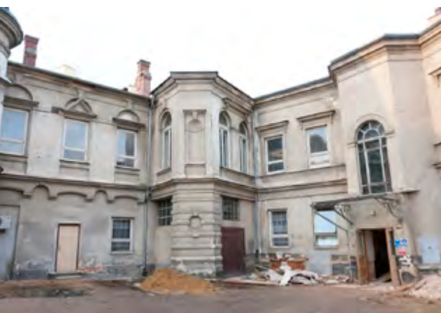
Nádvoří knihovny před rekonstrukcí. Foto: Archiv SZM.
