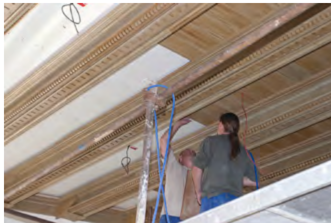
Instalace restaurovaného dřevěného stropu. Foto: Archiv SZM.
