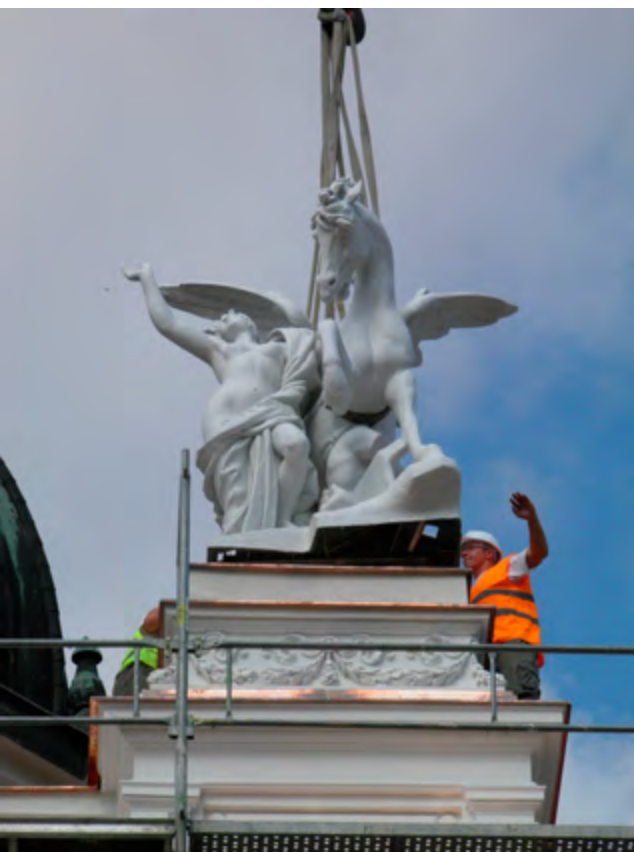
Instalace sousoší Pegasů. Foto: B. Honková.
