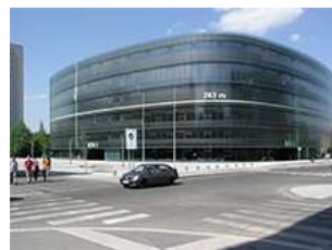
NTK z rohu Technické a Studentské ulice, nechybí ani kóty udávající výšku a obvod budovy...
