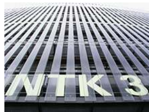
Nápisy nad vchody do NTK i kóty na fasádě z fluorescentní fólie se přes den nabíjí a v noci lehce světélkují
