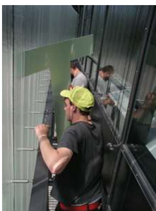
Montáž nápisu „NTK“ na budovu
