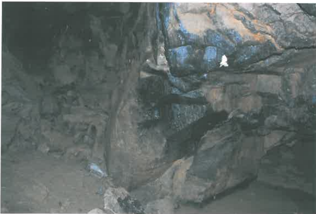
Obr. 4 Pilíř v komoře K3, na kterém bylo provedeno ultrazvukové prozařování (foto: Lednická)
