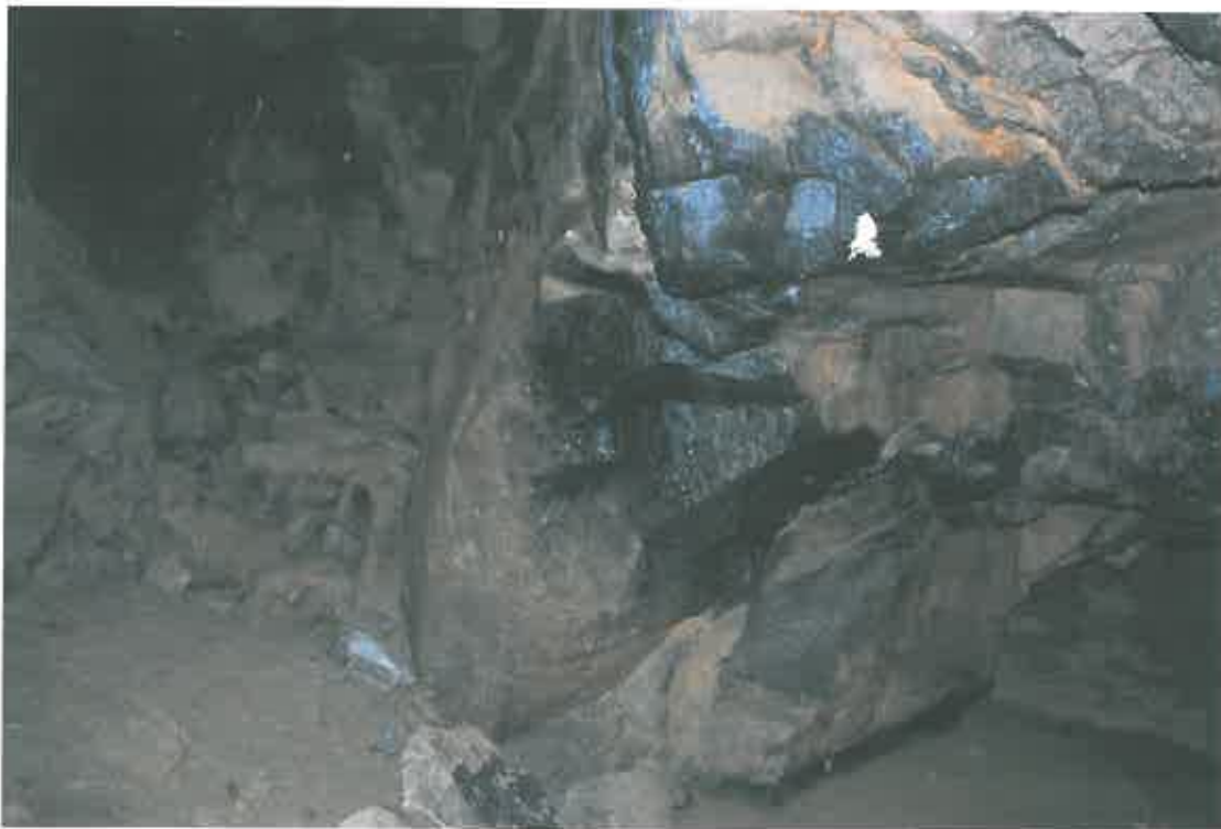
Obr. 4 Pilíř v komoře K3, na kterém bylo provedeno ultrazvukové prozařování (foto: Lednická)
