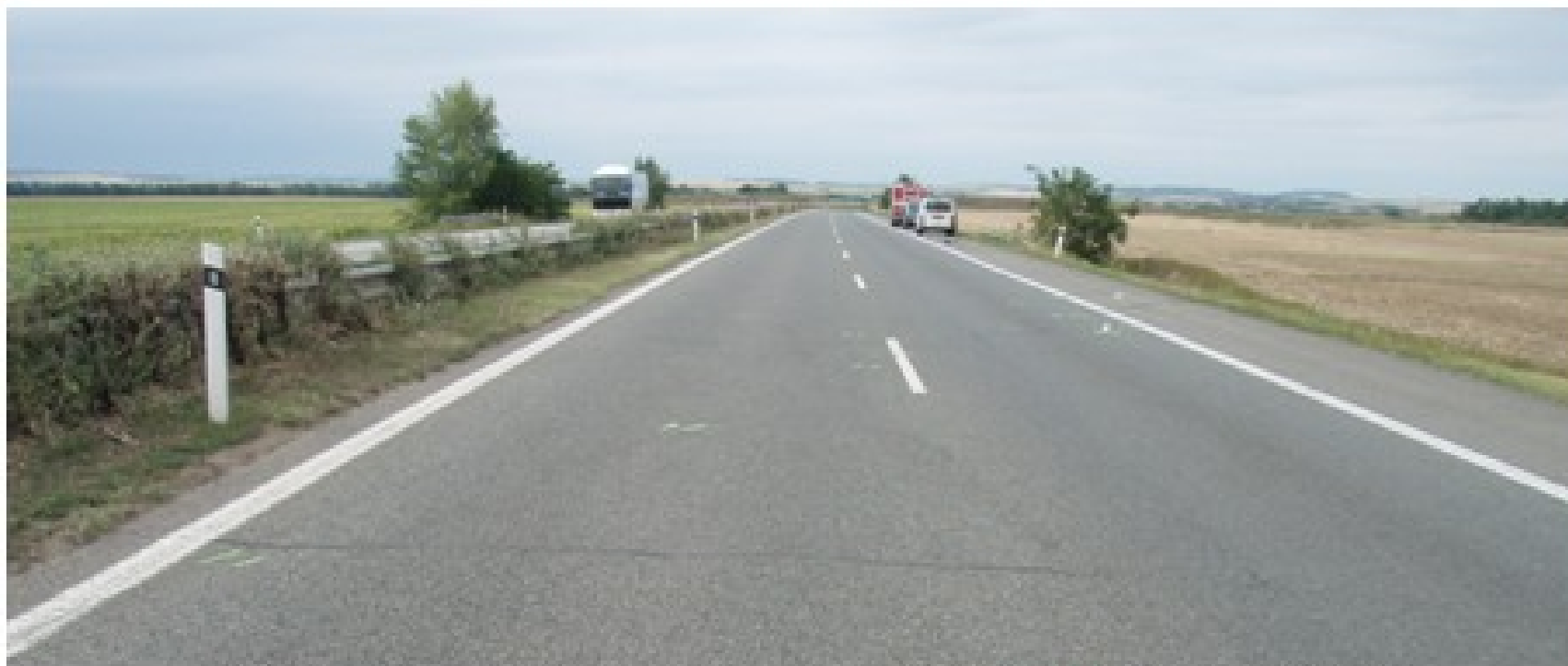
Obr. 5-1 – Místo DII na R. 52, vpravo je skrytý 3,5 m hluboký příkop
