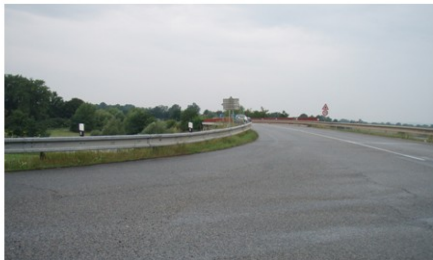
Obr. 5-1 – Pohled vlevo na silnici II/416 ve směru od Pohořelic z místa řidiče vozidla stojícího na vedlejší komunikaci – rampy ze silnice R52
