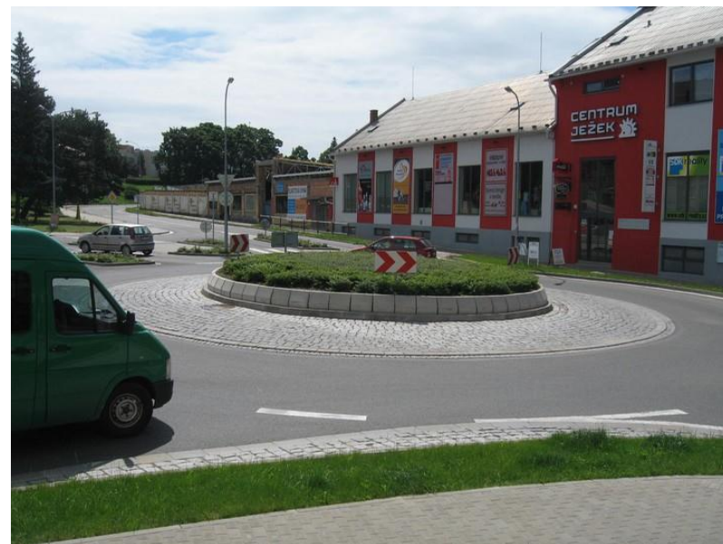
Křižovatka po realizaci
