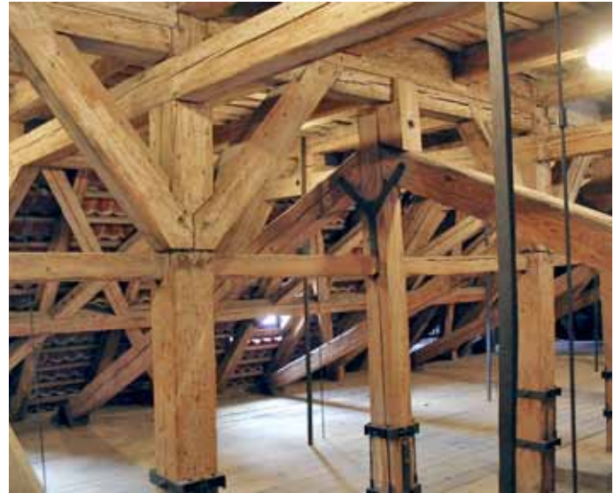
Obr. 10: Historický krov z masivních prvků v památkově chráněném objektu
