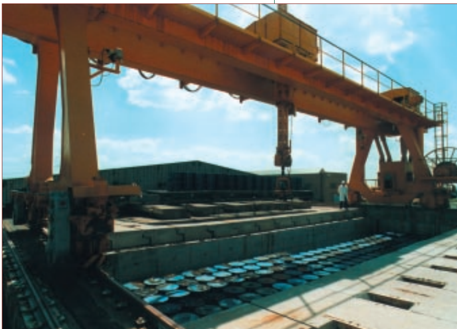
Pojízdný jeřáb na úložišti radioaktivních odpadů Dukovany
