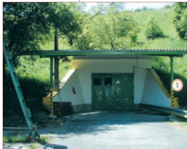
Vstup do podzemních prostor úložiště radioaktivních odpadů Richard
