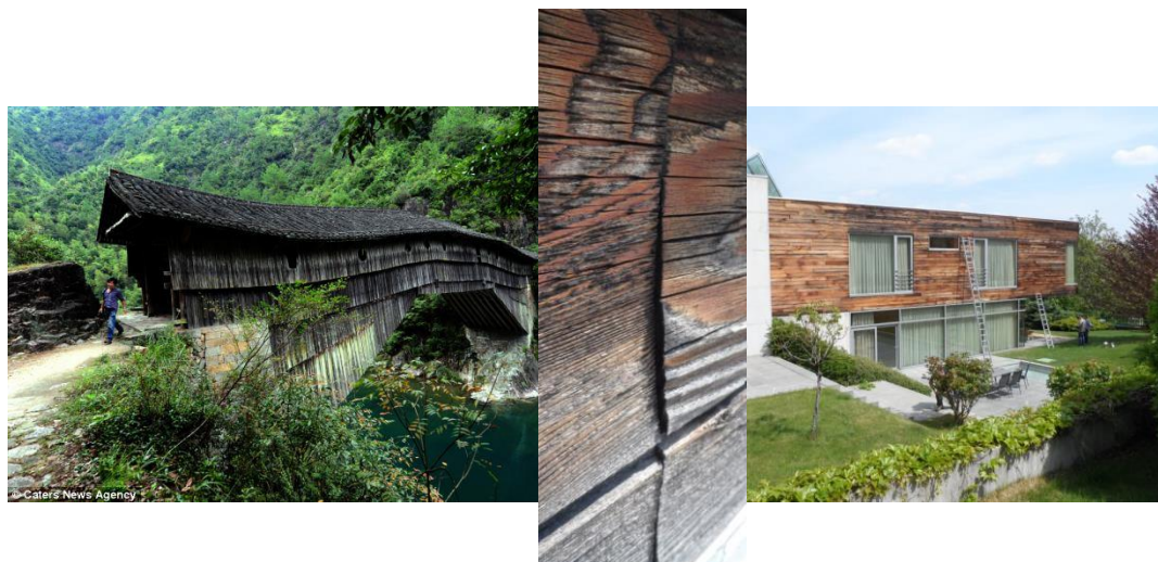
Obr. 3 Životnost dřívějších staveb a dřeva na nich použitého ve srovnání s dnešní stavbou (vlevo 1000 let starý dřevěný most v Číně, Foto Caters News Agency, vpravo 5 let stará budova residence velvyslance ČR v Budapešti, Foto: archiv Výzkumného a vývojového ústavu dřevařského, Praha, s.p.).
