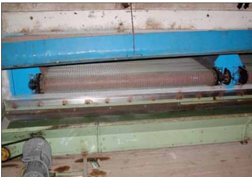
Obr. 6: Detail vyústění výsypu chmele a pohon sběrného pásu
